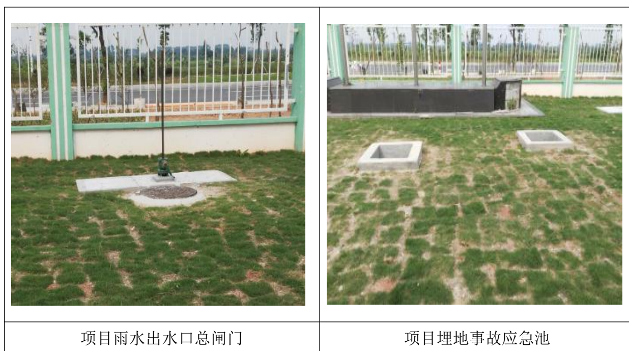
图 4-3 事故废水风险防范现场图片
