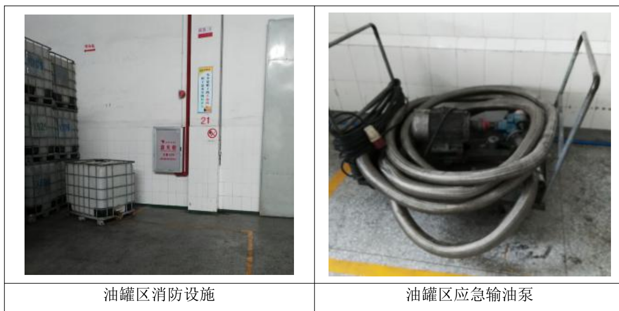
图 4-3 芝麻油库风险防范现场图片
