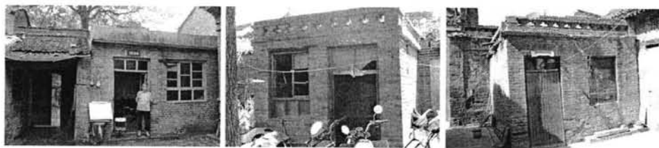
图 3-4 七八十年代搭建的平屋顶厨房
