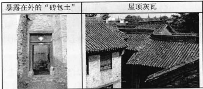
图 3-46 围护结构墙体与屋顶
