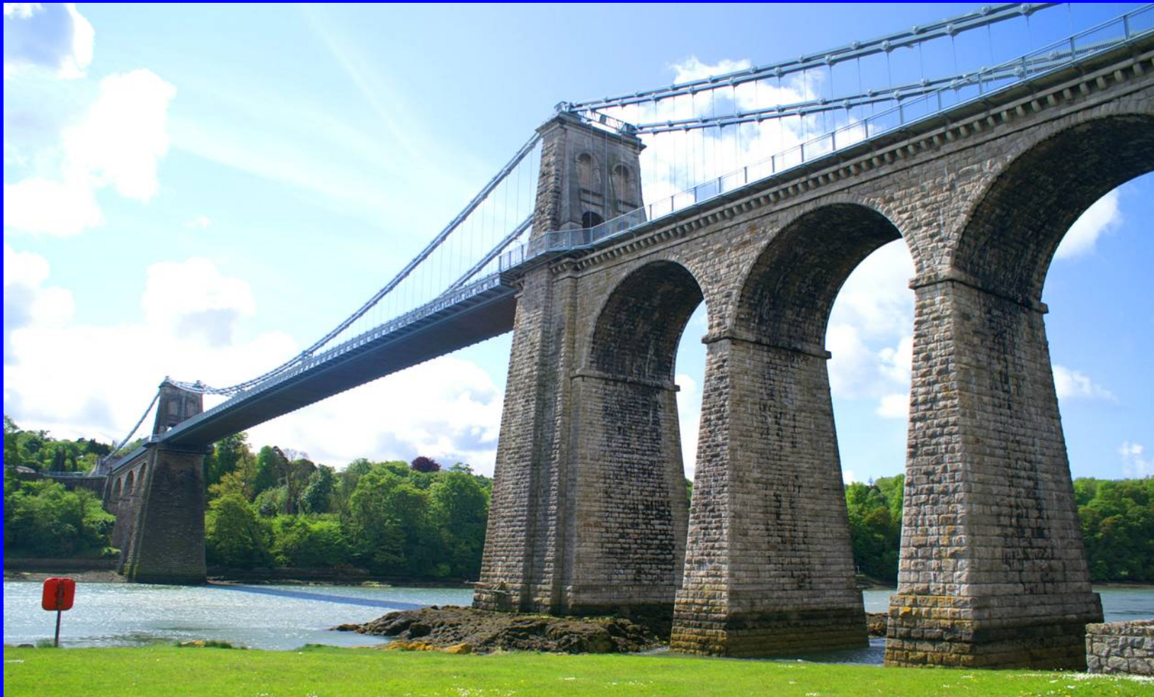
麦纳海峡桥 1826年建成，主跨177米 采用锻铁作为主缆 本桥于1940年更新
