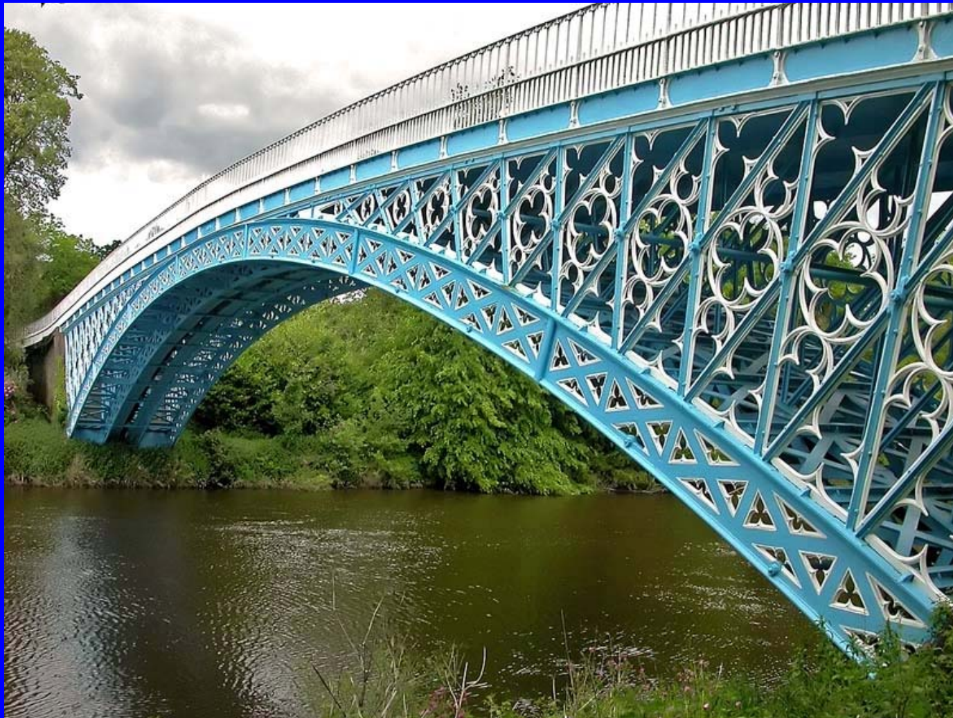
伊顿霍尔桥 1824年建成，主跨45.75米。无铰桁架拱。
