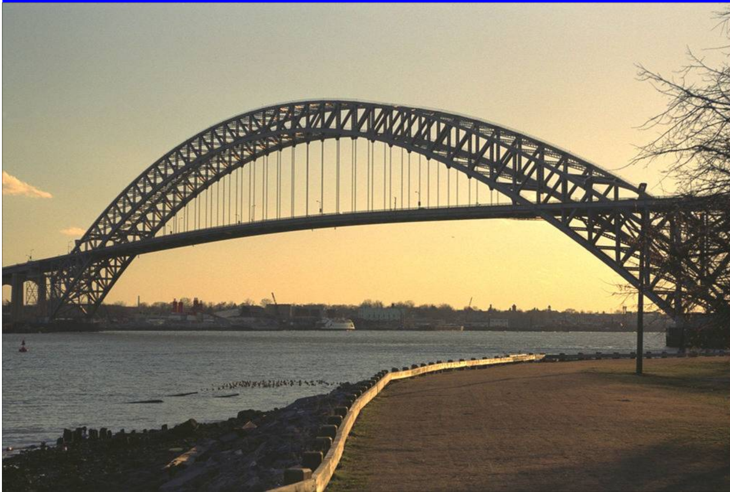
Bayonne bridge 1931年建成 主跨504米。 跨度只比悉尼桥大25in，荷载较小，架设也比较容易。
