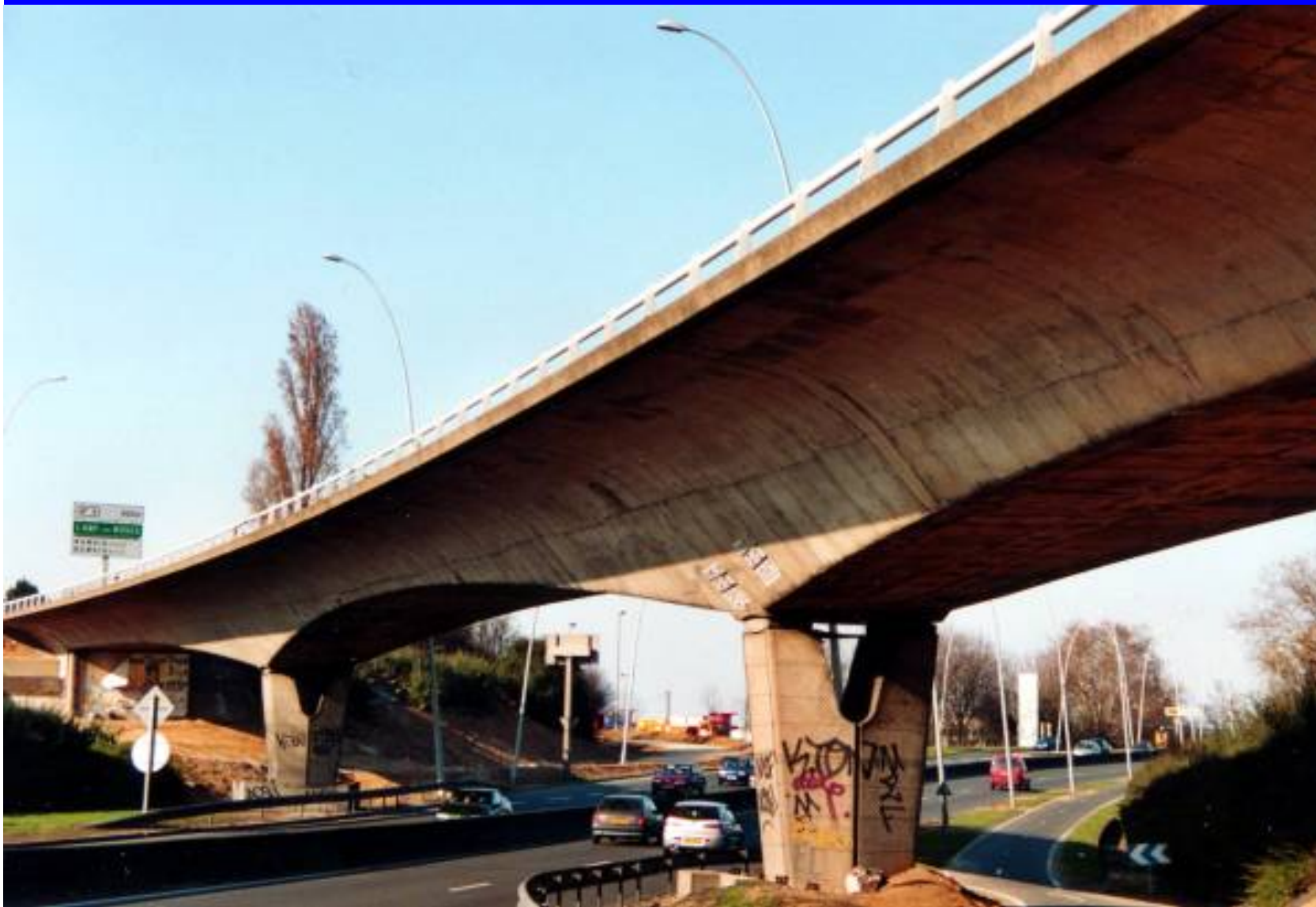
Orly 桥 主跨53.4米， 1958年建成， PC连续梁桥
