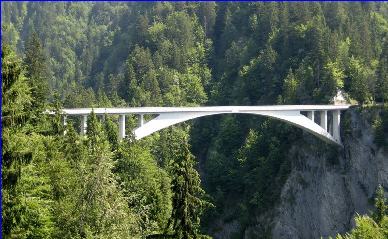
Salginatobel Bridge 主跨90米，1930年建成。三铰拱。支架法施工。 他设计的最大跨度的桥，桥的壮丽景色使它成为马拉尔最著名的设计。
