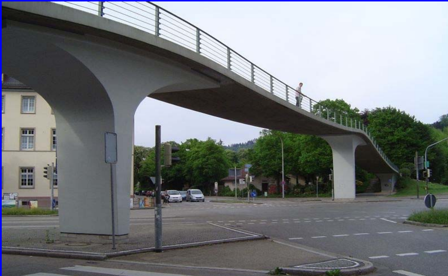
Freiburg市的悬带桥，1970年，人行PC悬带桥。25.50+30.0+30.45m 桥面宽度4 m。
