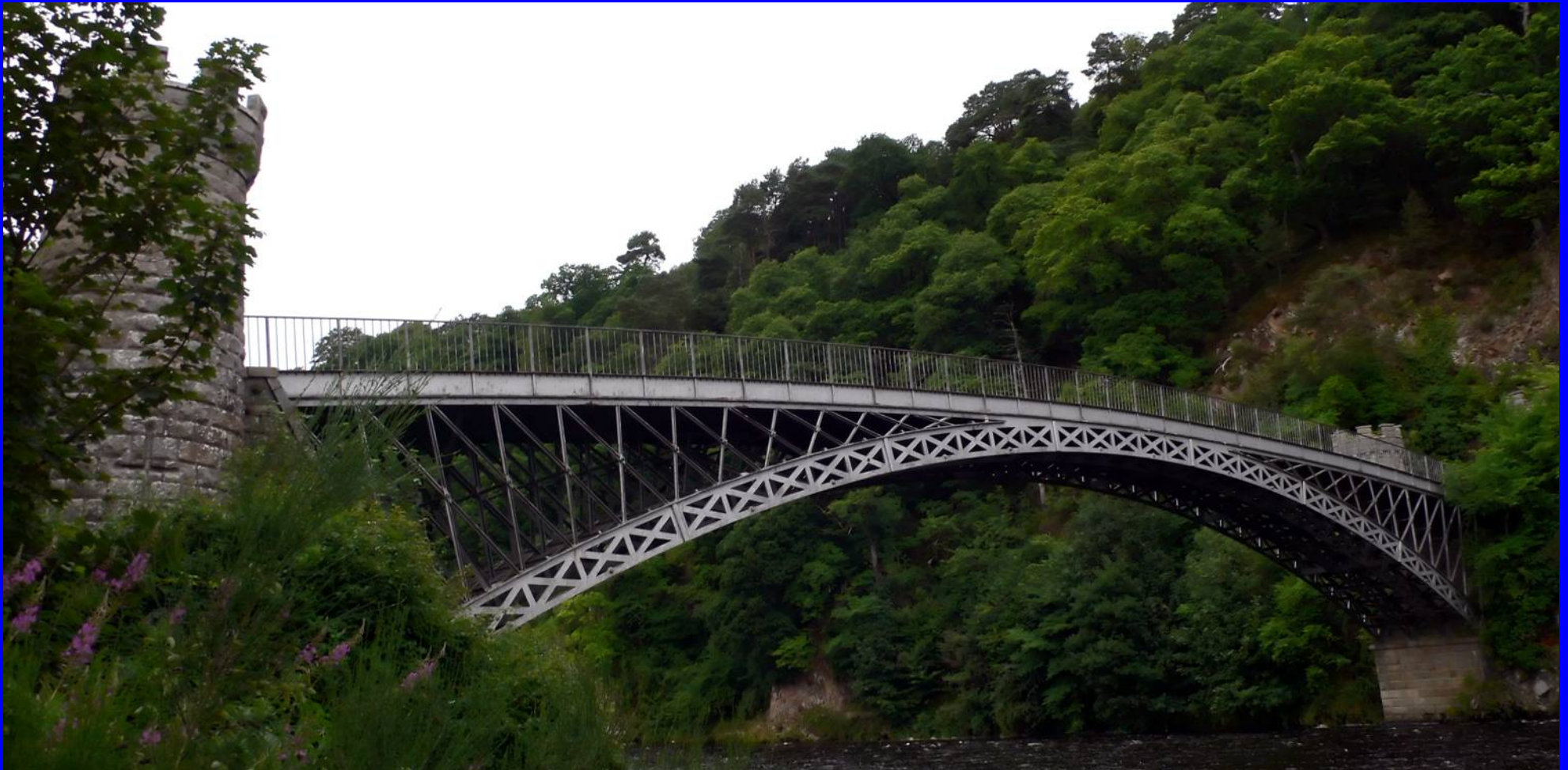
克拉雷齐桥 1814年建成，主跨46米。桁架无铰拱。
