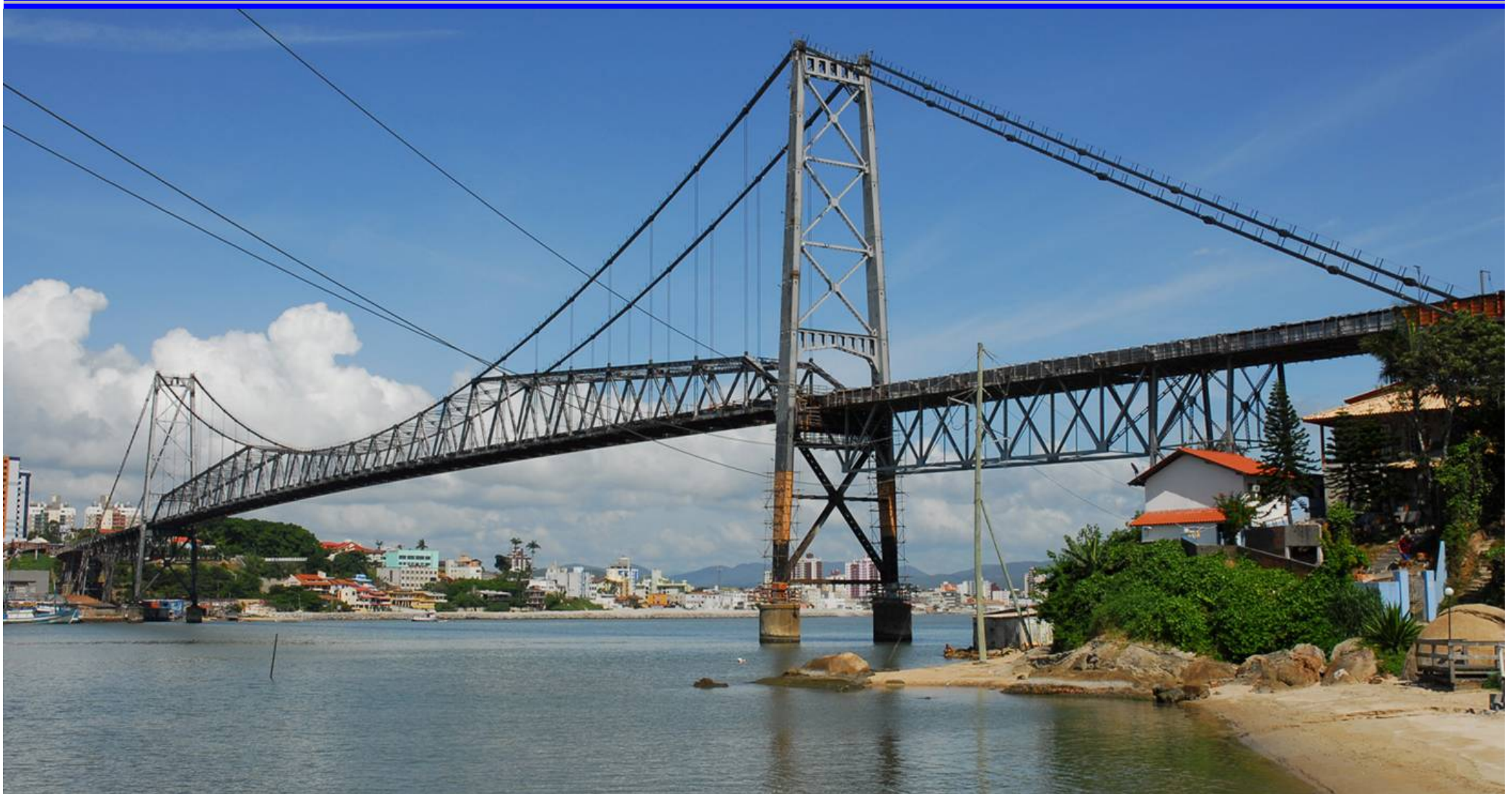
弗洛里纳波利斯桥，1926年建成，主跨339.7m，塔下设摆轴。眼杆与中部桁梁上弦结合。
