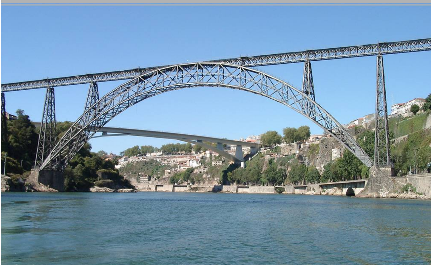
Pia Maria bridge 铁路桥，主跨160米锻铁新月拱桥，1877年建成采用铰支座、由拱顶到拱角横向逐渐变宽。
