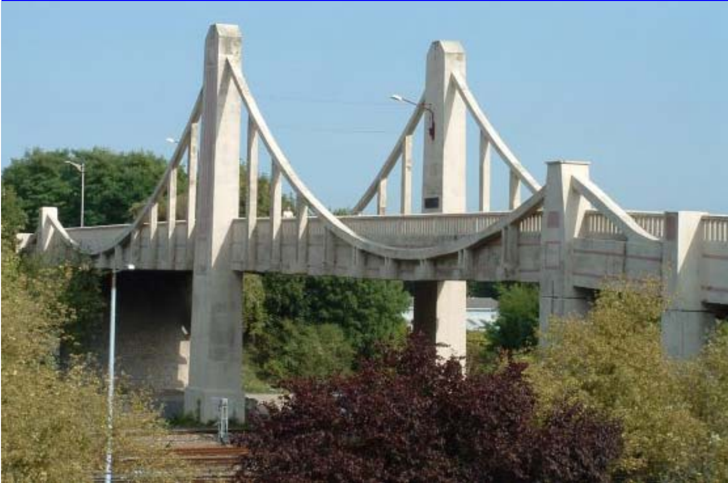
三塔混凝土悬索桥 1928年建成， 6.8+37+37+6.8米， 自锚悬索桥。
