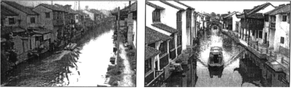
山塘街沿河（通贵桥方向）整治前后的面貌比较（图1）
