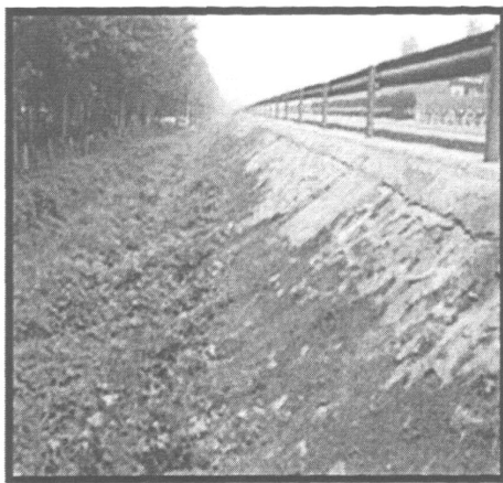
图 6-14 浆砌片石防护
