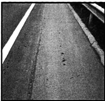
图 2-4 纵向裂缝
