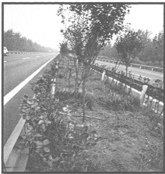
图 3-7 大修时被打开的中央分隔带
