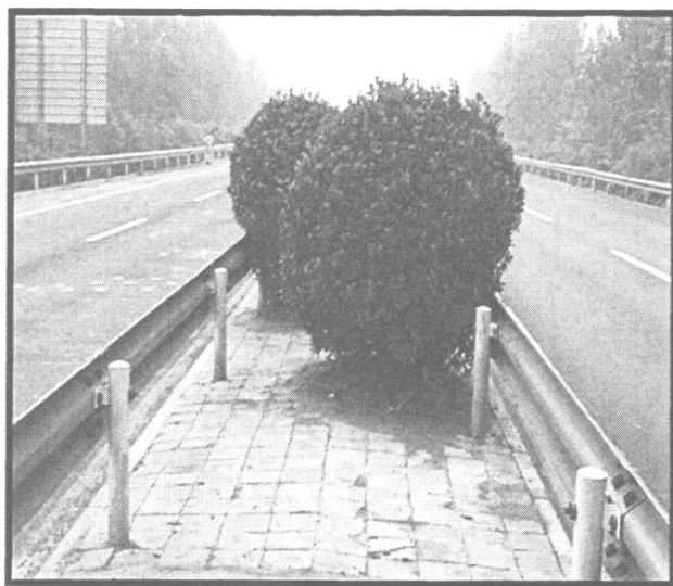
图 3-6 采用封闭方式的中央分隔带
