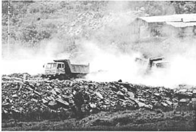
图 1-1 公路施工工地运输过程中产生的灰尘
