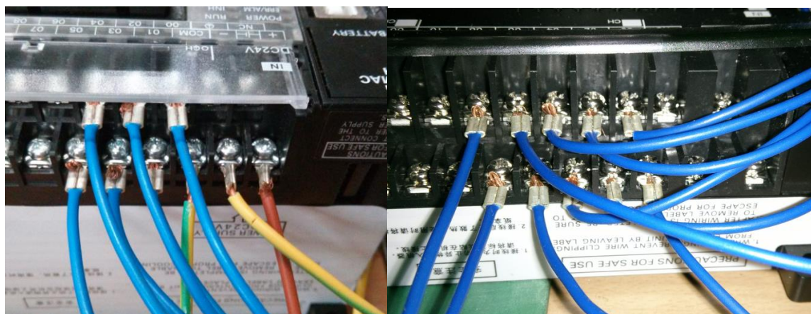
图 5-1 PLC 输入端连接实物图
