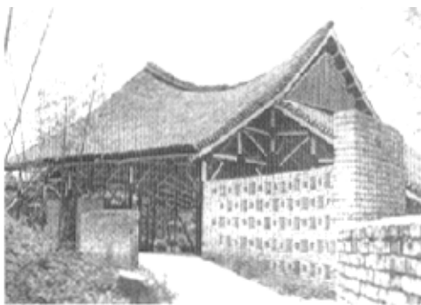
图 3-37 松江方塔园茶室庑殿顶的屋顶形式
