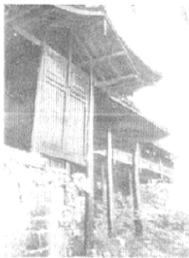
图 1-6 峨眉山纯阳殿的吊脚楼 (图片来源:《中国园林建筑》)
