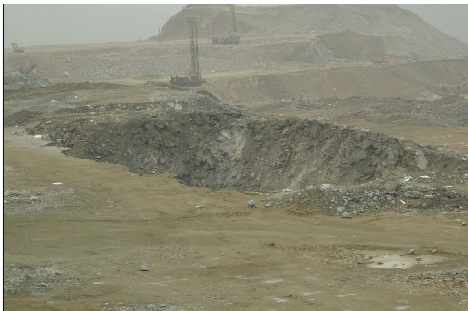
图 5-16 1438-1 水平空区在周边台阶爆破后坍塌一角
