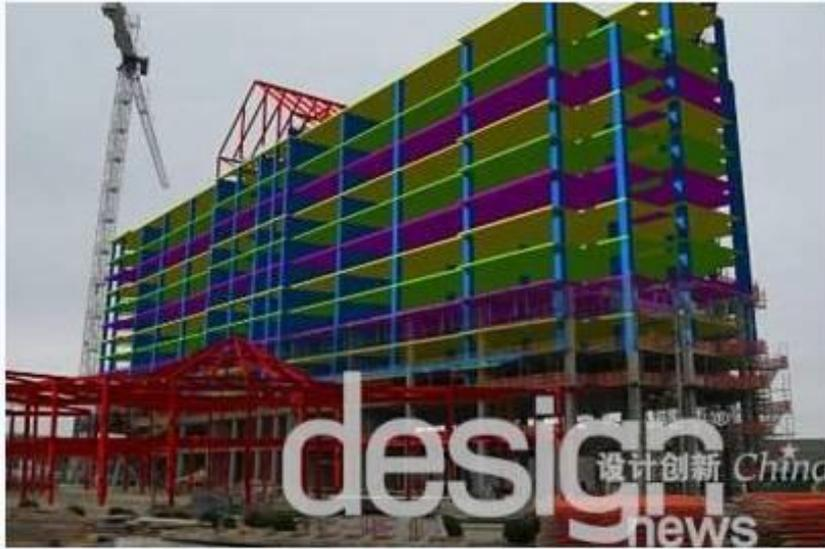
图1.3 叠加在现场照片上的建筑模型
